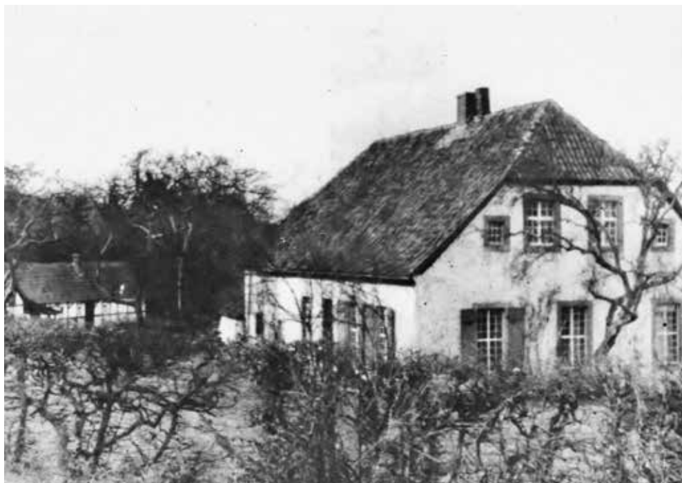
Das 1809 erbaute Gebäude an der heutigen Sudenfelder Straße beherbergte bis 1883 die Volksschule Niedermark. Wilhelm Rethmann besuchte sie von 1830 bis 1837. Aufnahme um 1900.
